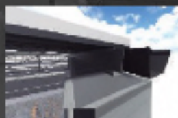
Canalón y monten
