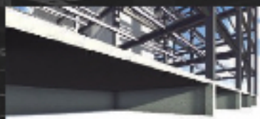
Cajón de cimentación
